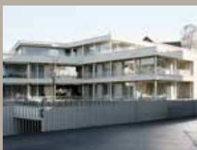
Mehrfamilienhaus Holzhäusern, Menzingen
